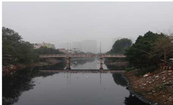
Hình 4. Đoạn sông Nhuệ có cầu Hữu Hòa (Đoạn tiếp nhận nước sông Tô Lịch)
