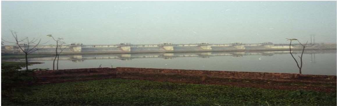
Hình 1. Đập Đáy nhìn từ hạ lưu
