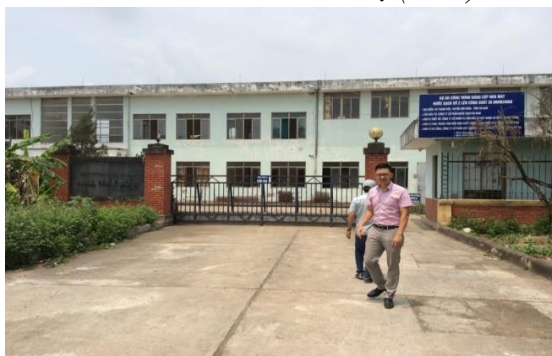
Hình 20. Nhà máy nước Thanh Sơn
