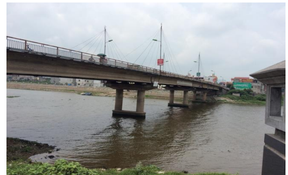
Hình 7. Điểm cầu Hồng Phú (N10)
