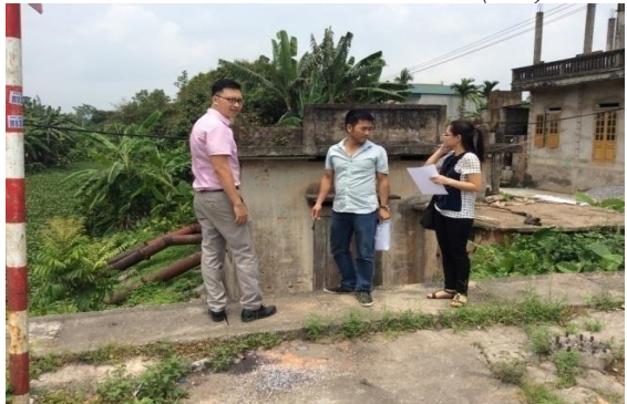
Hình 11. Trạm bơm Thanh Nộn (Đ6)
