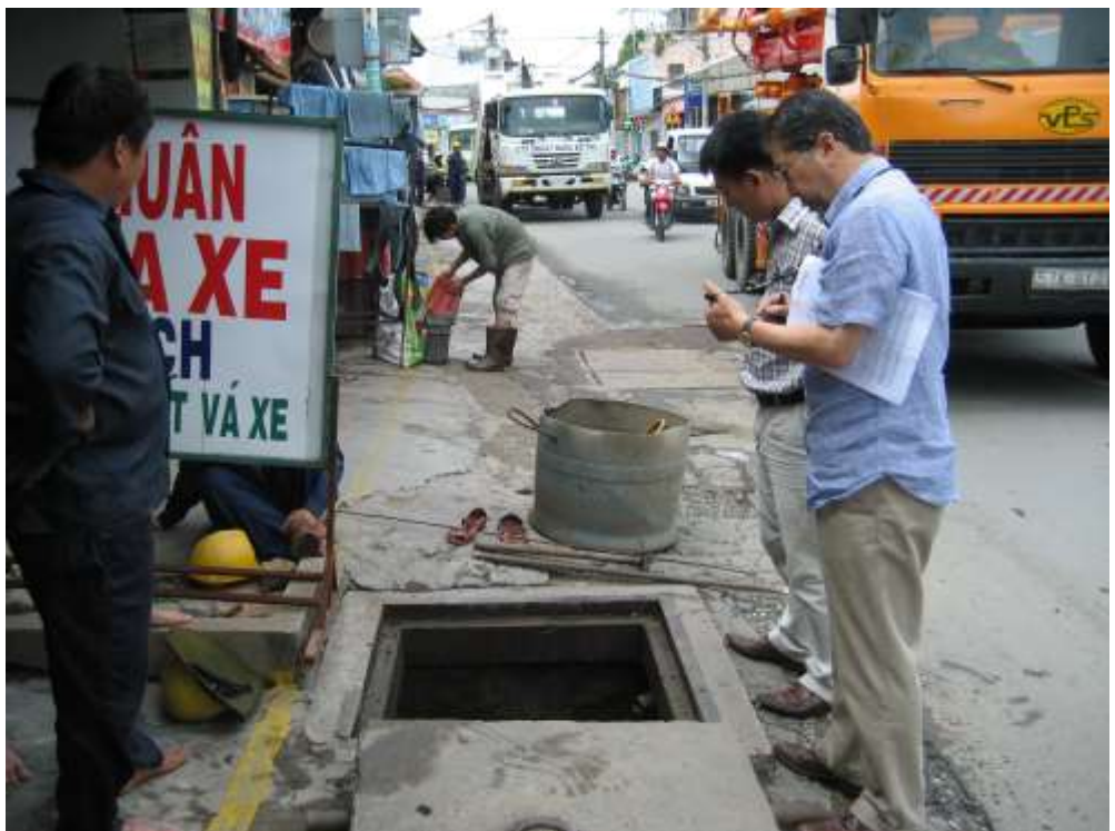
Hình III.21: Lấy mẫu nước trong hệ thống thu gom nước thải LV1
